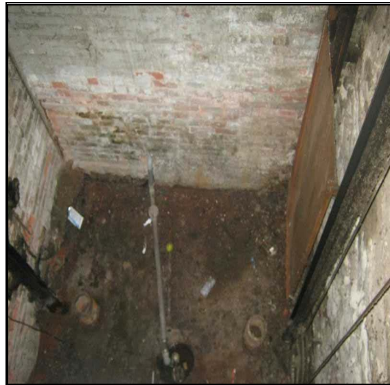
Puits du monte-charge Source : CSST
