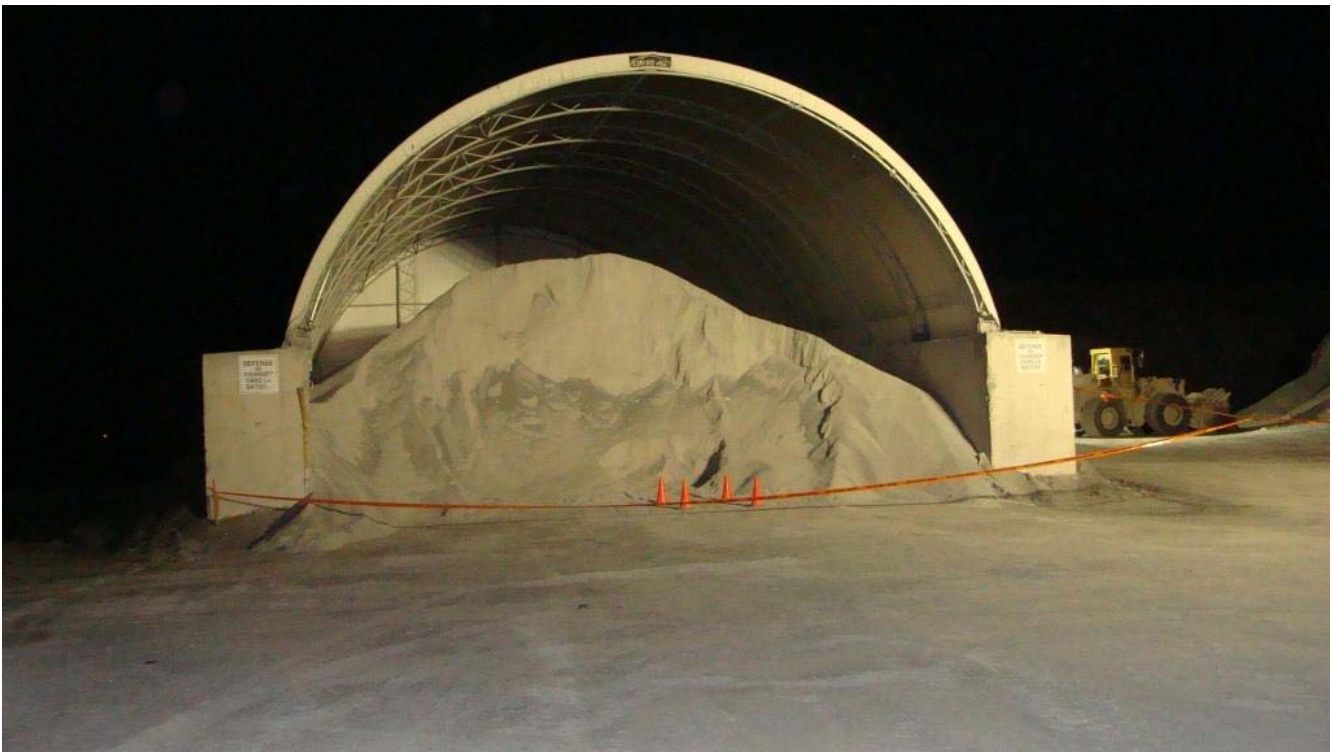
Aperçu du lieu de l'accident (Source : CSST)
