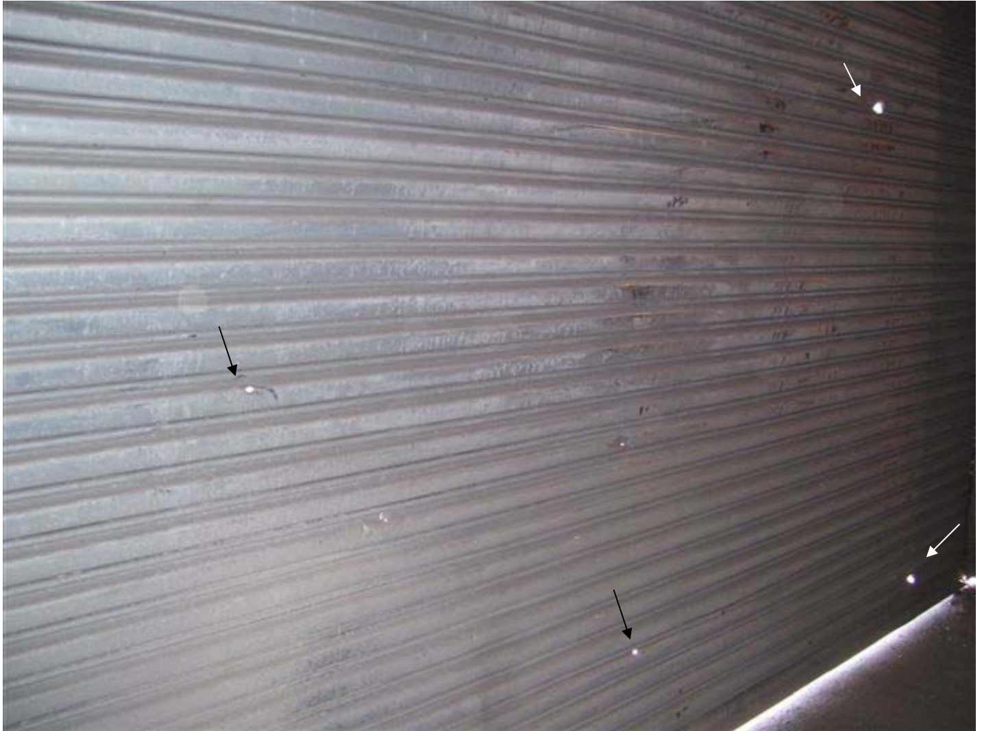
Figure 5 : perforations dans une porte métallique située à proximité du four #2 et produits lors de tir au fusil.
